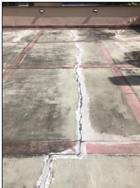
FOTO 07 – RACHADURAS NA LAJE
