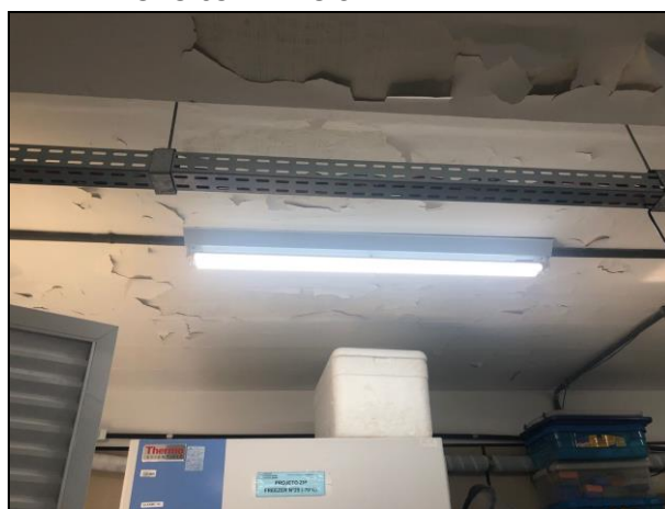
FOTO 06 – RACHADURAS NA LAJE
