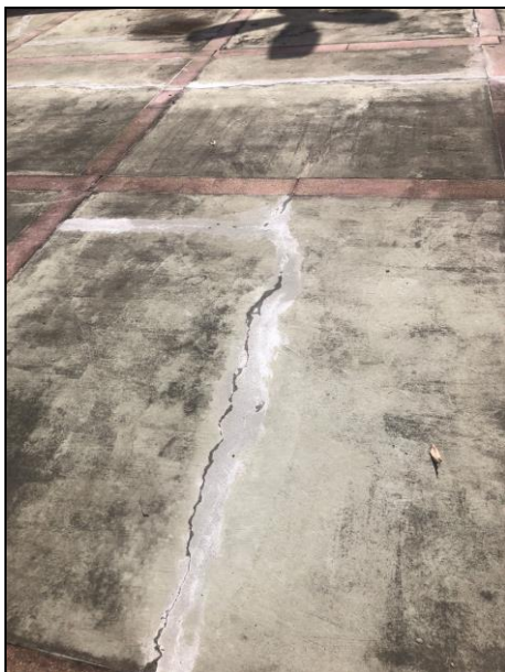
FOTO 06 – RACHADURAS NA LAJE
