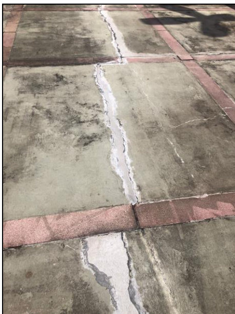
FOTO 06 – RACHADURAS NA LAJE
