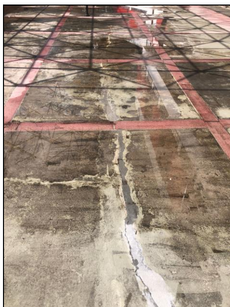
FOTO 06 – RACHADURAS NA LAJE
