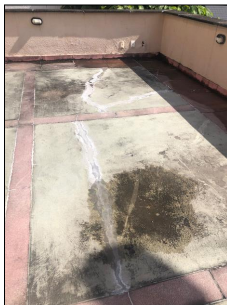
FOTO 07 – RACHADURAS NA LAJE
