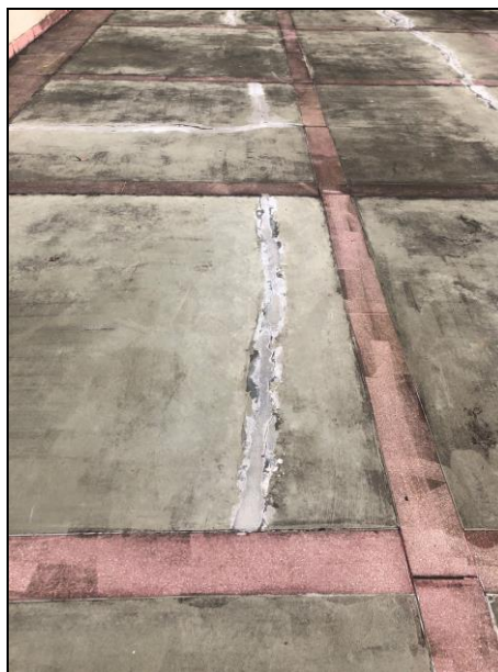
FOTO 07 – RACHADURAS NA LAJE
