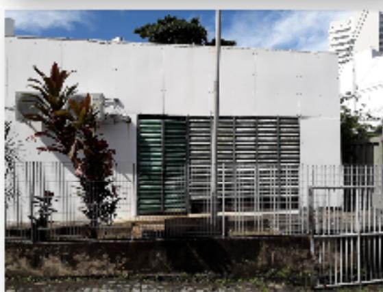
Fotos dos acessos para entrada dos novos Chillers: Pode ser pela lateral da CAG (com remoção dos elementos de fechamento da fachada) ou pela abertura superior (teto) da CAG. A melhor solução deverá ser definida pela contratada com concordância do IGM/FIOCRUZ-BA.
