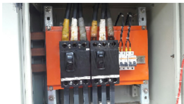
Disjuntor geral que atendem aos dois chillers
