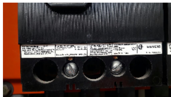
Disjuntor geral que atendem aos dois chillers
