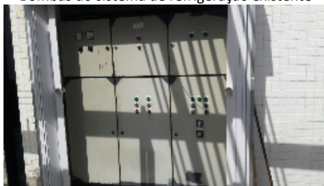
Quadro elétrico que atende ao sistema de refrigeração
