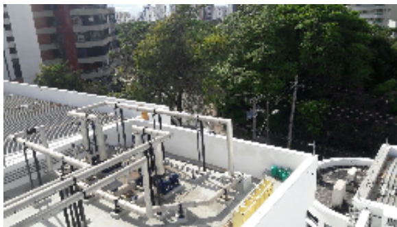
Bombas do sistema de refrigeração existente
