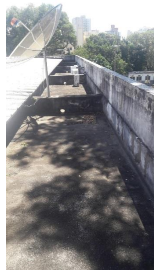
Calhas a serem impermeabilizadas
