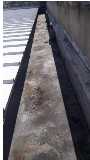
Calhas a serem impermeabilizadas
