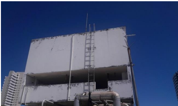
Reservatório a ser impermeabilizado internamente
