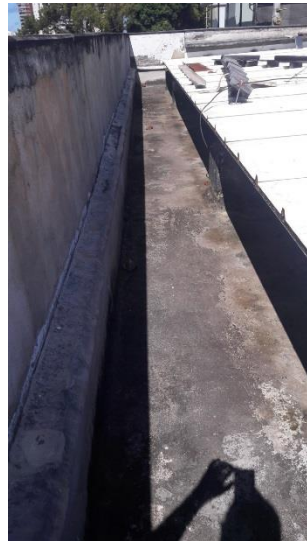
Calhas a serem impermeabilizadas
