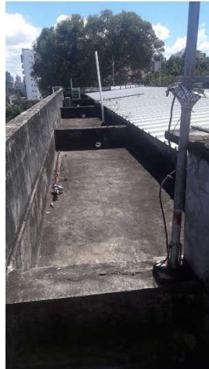
Calhas a serem impermeabilizadas
