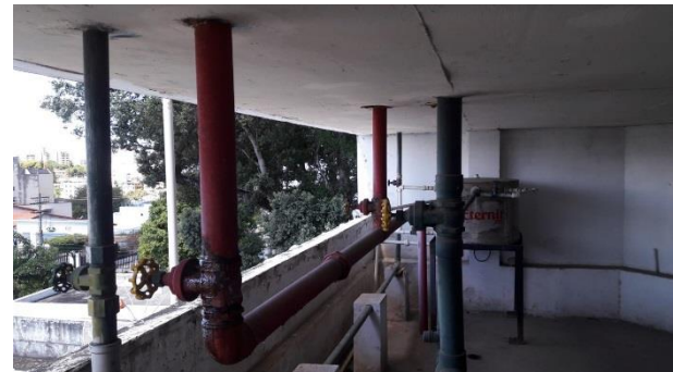
Tubulação (vermelha) a ser substituída
